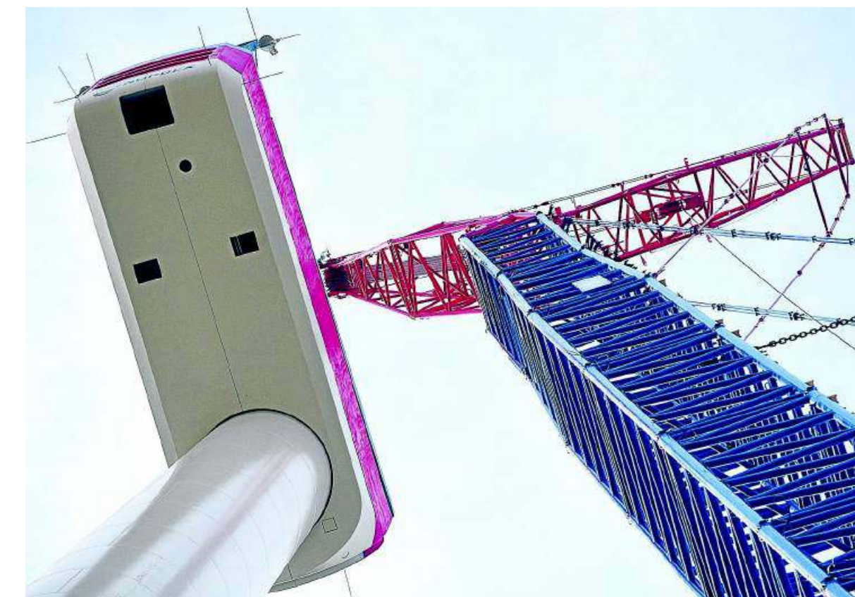
Die schwierigste Phase: die Montage der Gondel. Zwölf Meter ist das Maschinenhaus der Windenergieanlage lang, 4,5 Meter hoch – groß wie ein Lastwagen und vollgestopft mit modernster Technik.
